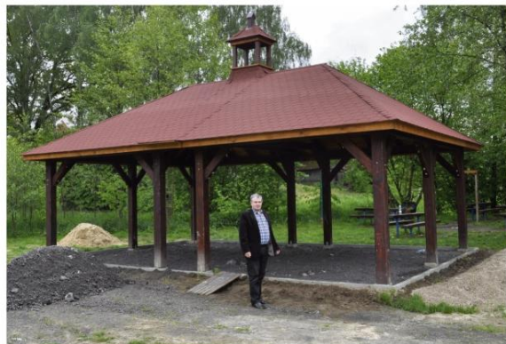
Maj 2016: altana prawie ukończona. Fot. Lech Chodacki
